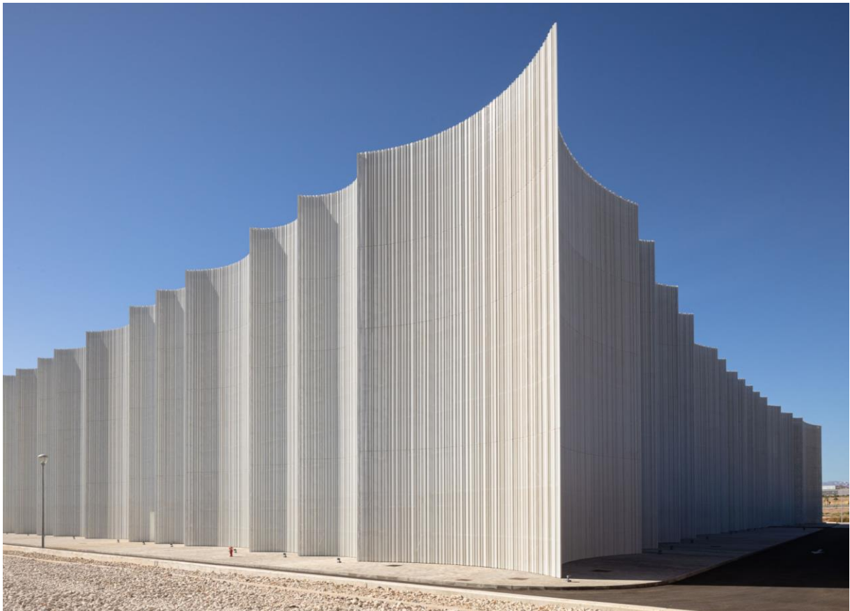
La fachada de zinc microperforado deja pasar la luz natural y protege el policarbonato de la radiación solar directa.
