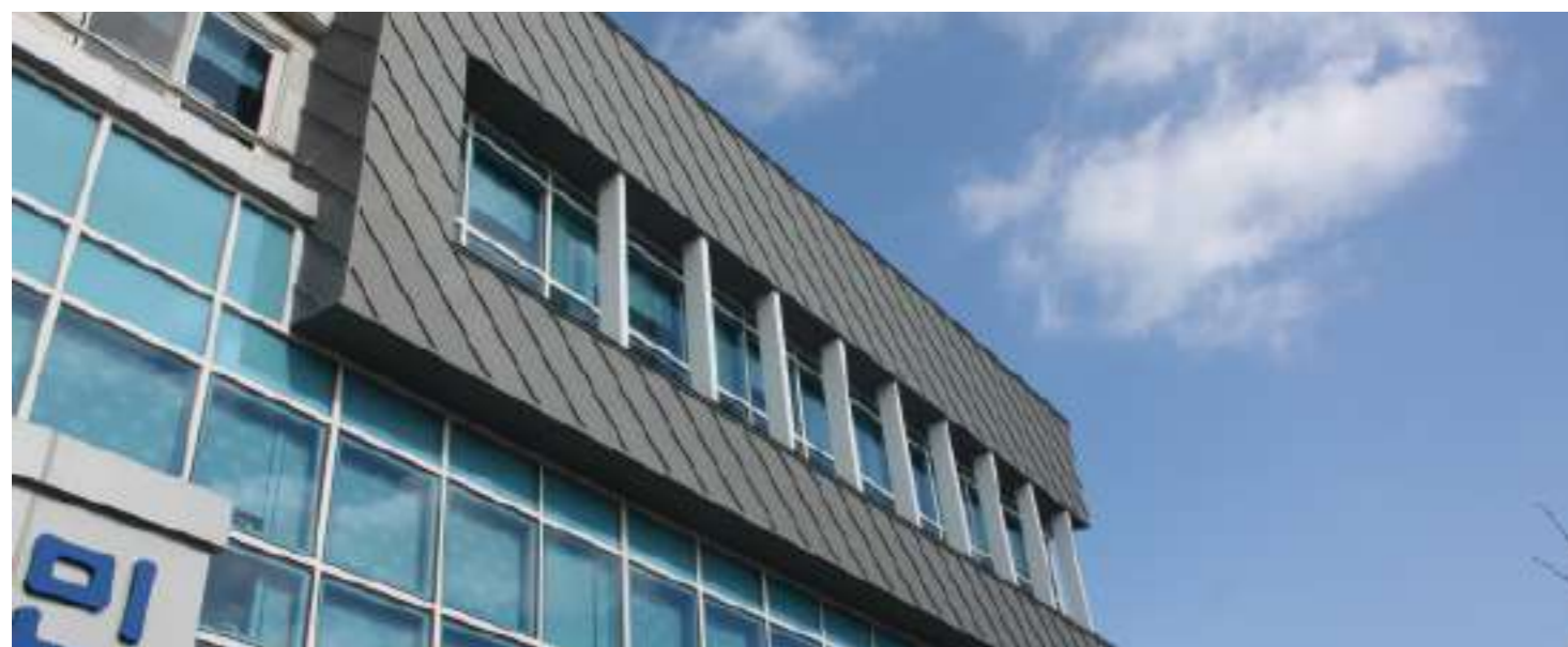
Junta alzada en ángulo colocado en vertical y horizontal
