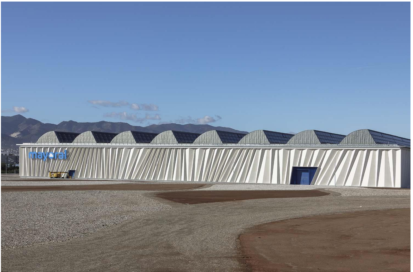
SYSTEM Arquitectos rehabilita una nave industrial textil de Intelhorce de 1963.
