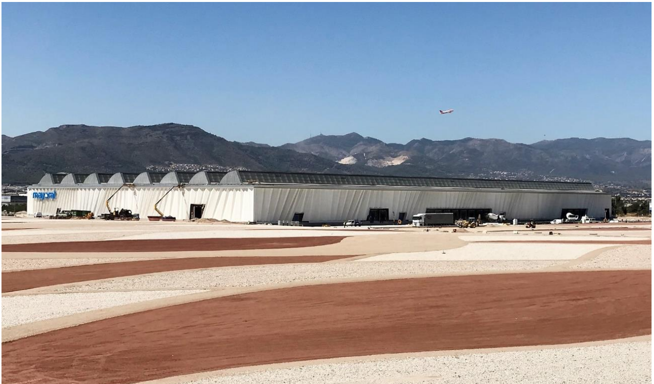
La materialidad del zinc como revestimiento de cubierta se adapta perfectamente a la concepción original de la fábrica. Fotografía: Rafael Urquiza Sánchez
