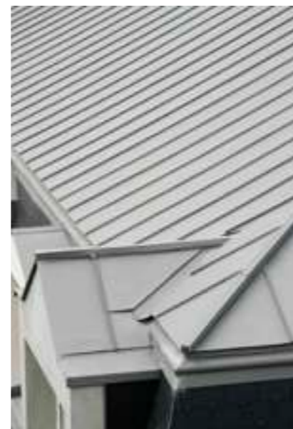
Perfil 'hembra' fijada con patillas y perfil 'macho'
