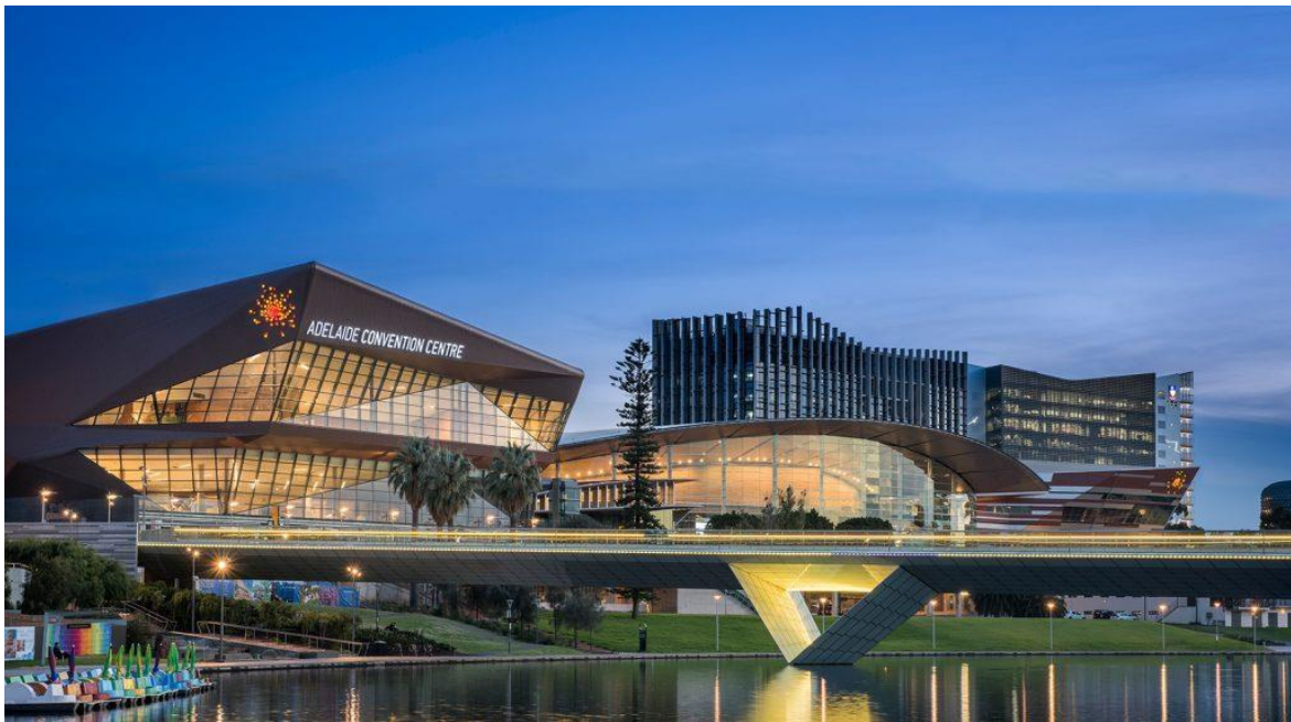
elZinc Ibérico et elZinc Rainbow rouge ont été choisis pour revêtir le centre de conventions d'Adélaïde, en Australie Architecte : Woods Agency
