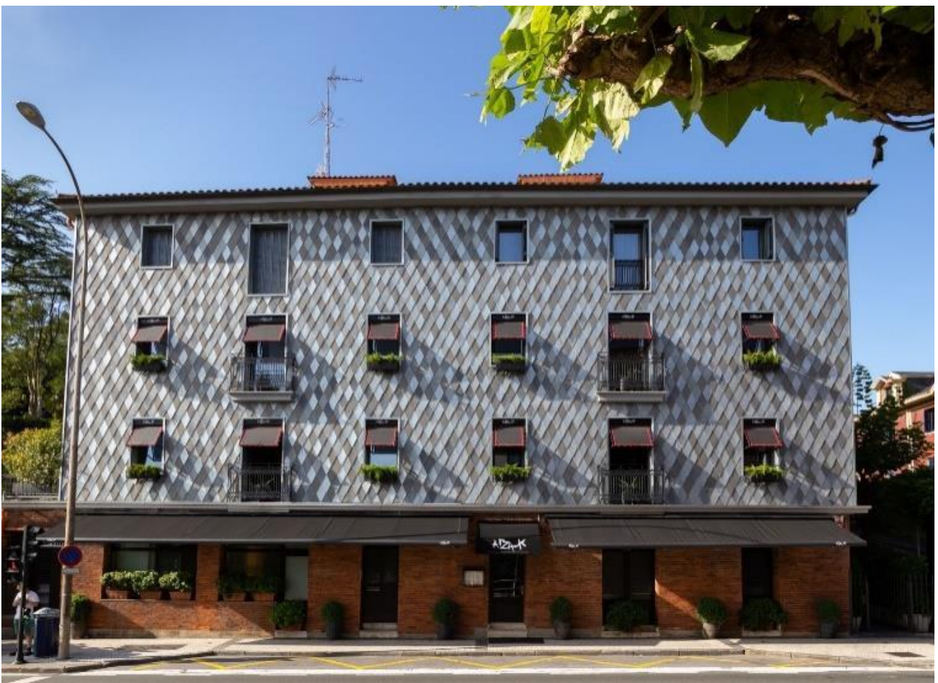
De nieuwe gevel van het restaurant geeft het restaurant meer karakter.
