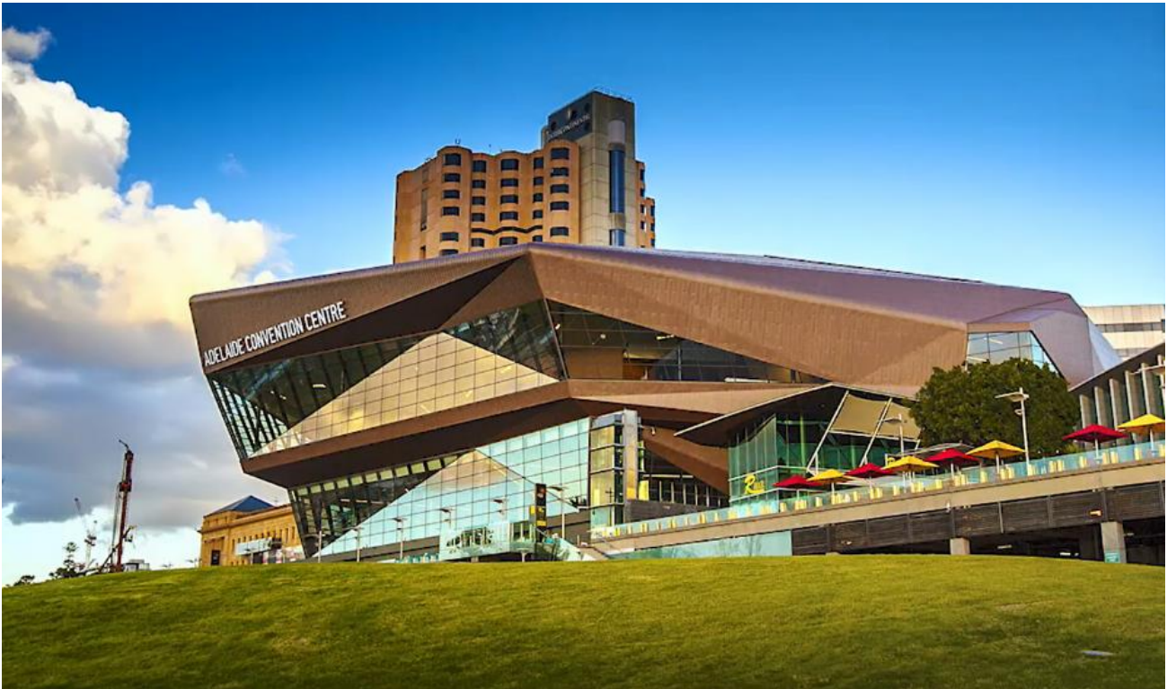
Su forma exterior y su revestimiento de zinc de color rojizo están inspirados en las formaciones rocosas de granito denominadas The Remarkables
