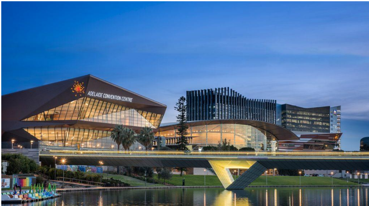
elZinc ibérico y elZinc Rainbow red fueron elegidos para revestir el Centro de Convenciones de Adelaide en Australia Arquitecto: Woods Bagot Adelaide
