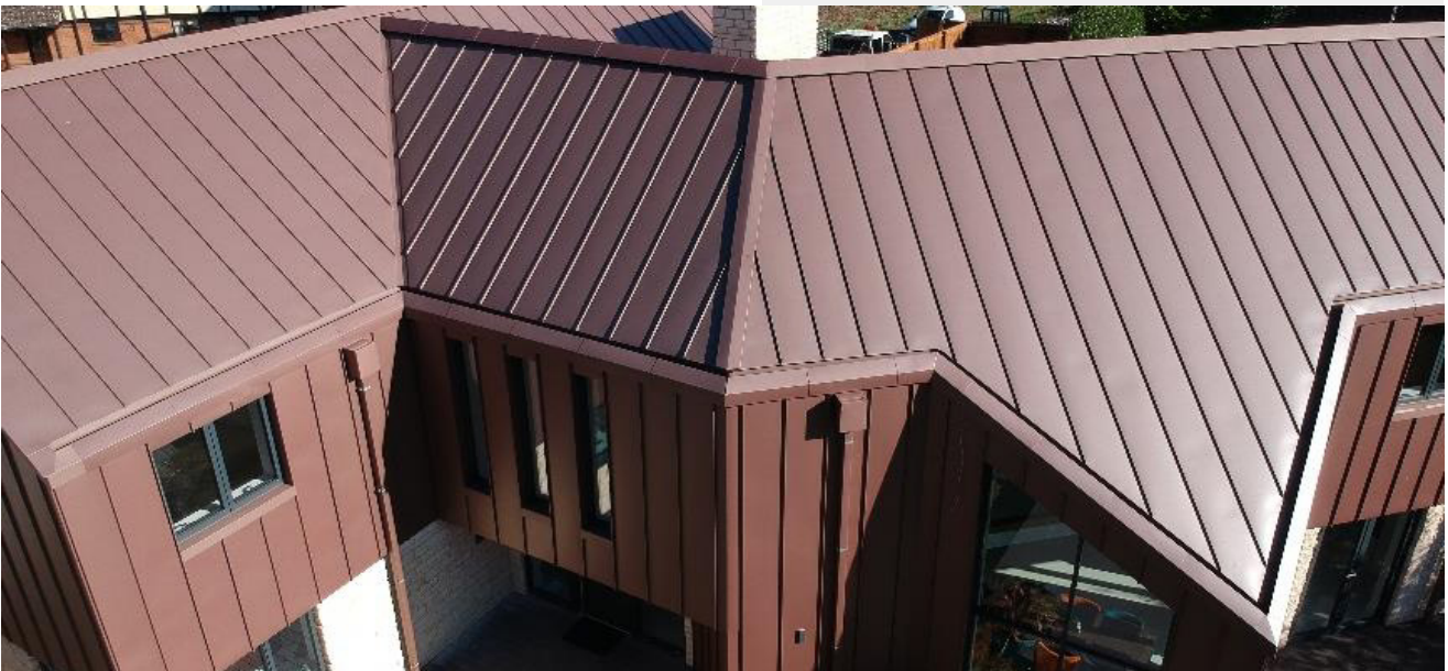
Los canalones en los aleros se retranquean y se ocultan dentro de la cubierta.
