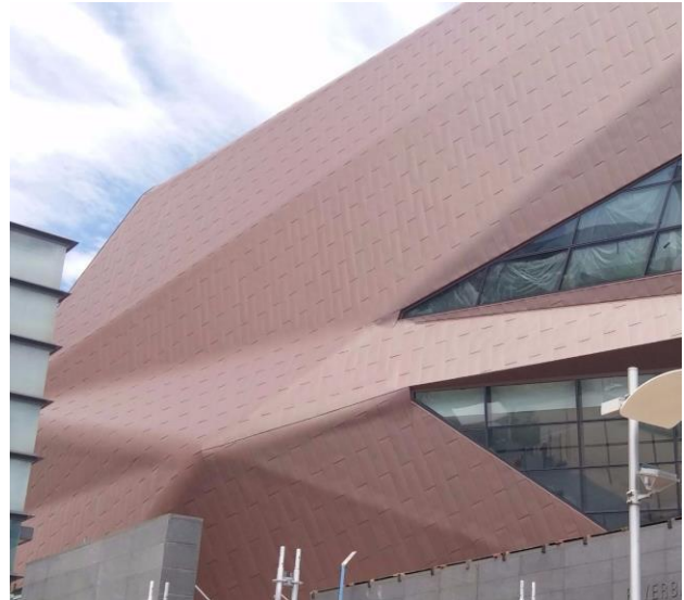
Der Kreuzstoß, an dem sechs Gratlinien zusammenlaufen
