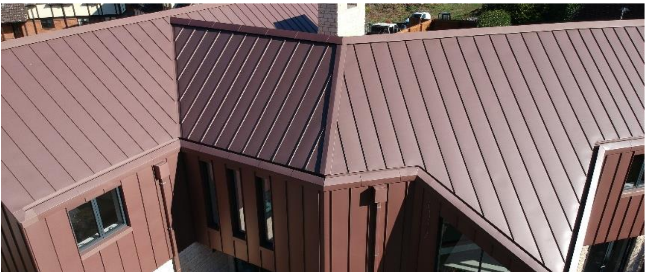
De goten in de overhangende dakranden werden naar achteren geplaatst en liggen verscholen in het dak.
